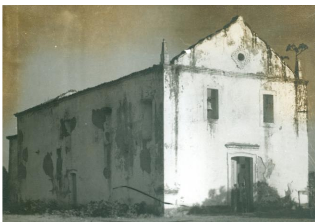
Figura 4 - Situação da Igreja de São Miguel Arcanjo em 1975.
