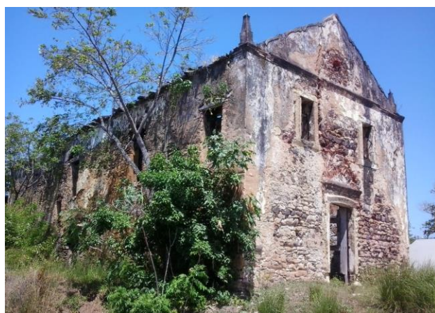
Figura 5 - Situação da Igreja de São Miguel Arcanjo em 2012.
